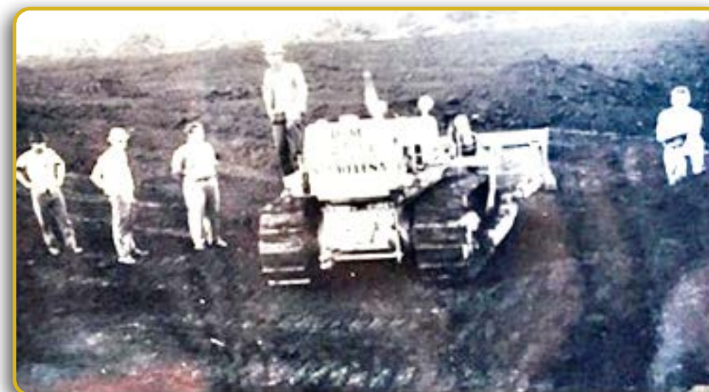
Foto 6: Prefeitura Municipal fazendo a 1ª Terraplanagem no Campo do União. Fonte: José Alberto Kozerski (Beto).
